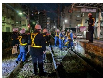
荒川保線班（夜間作業）
