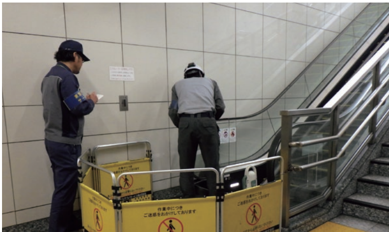
エスカレーターの保守点検 ▶
