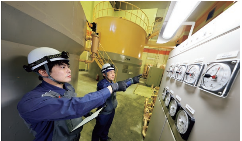
発電設備の保守点検 ▶
