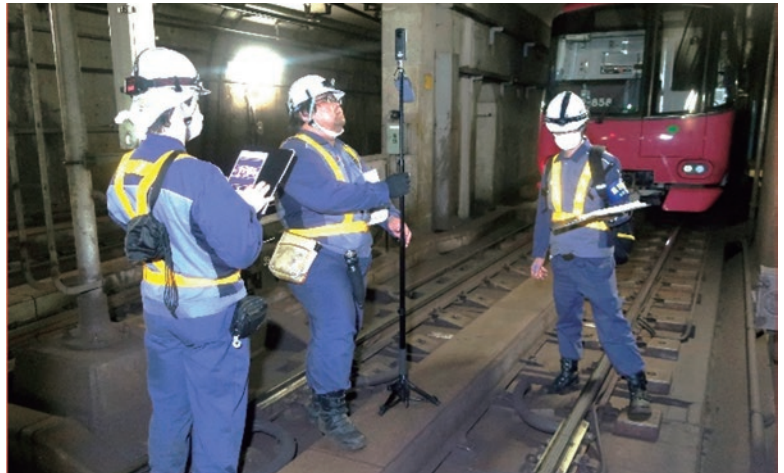
360度カメラによるトンネル内の撮影 ▶
