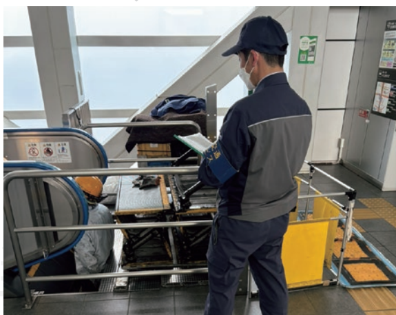
エスカレーターの保守点検 ▶
