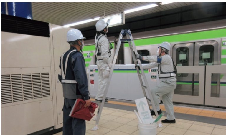
照明設備の点検清掃 ▶
