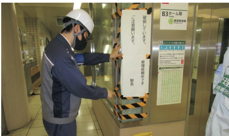
修繕工事個所の確認 ▶
