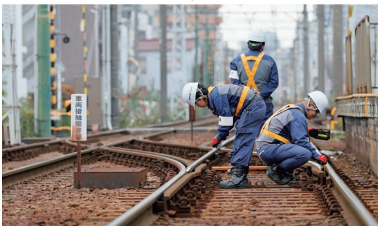
軌道の保守管理 ▶
