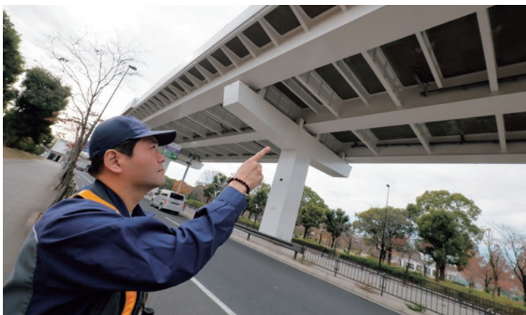
走行路の点検 ▶
