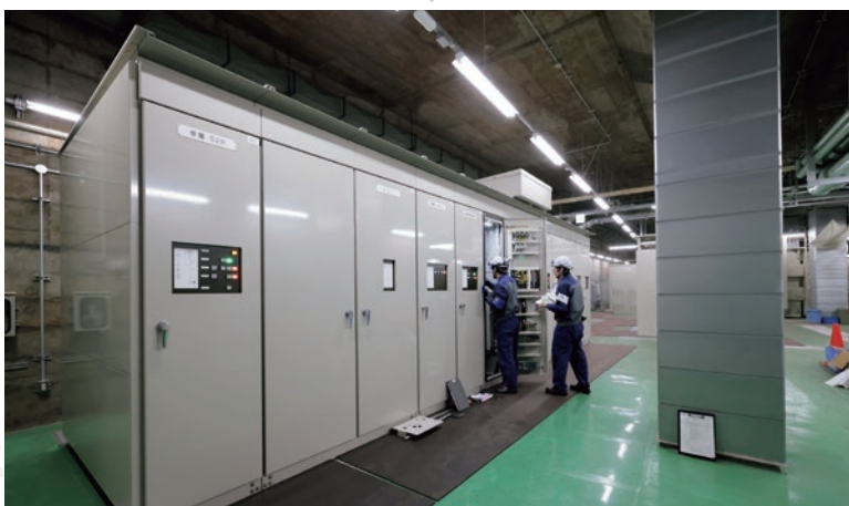
変電設備の保守点検 ▶
