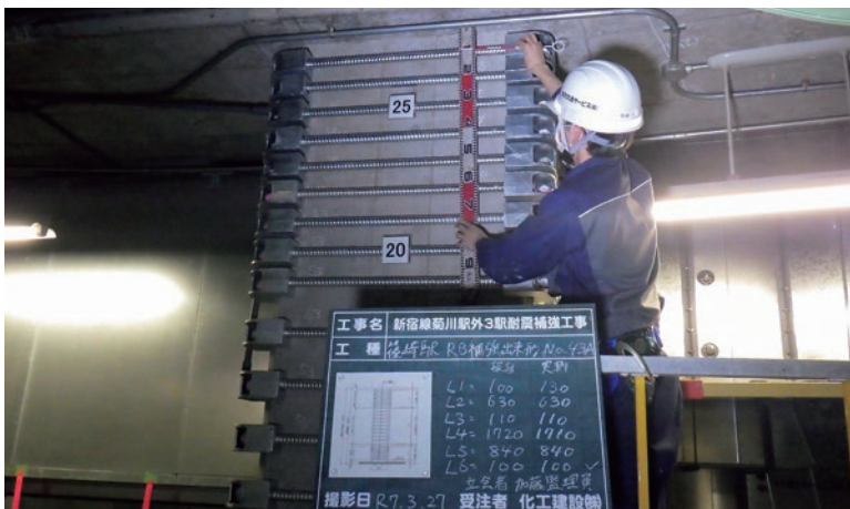
駅の柱の耐震工事監理 ▶
