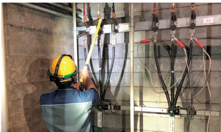
電気設備の工事監理 ▶
