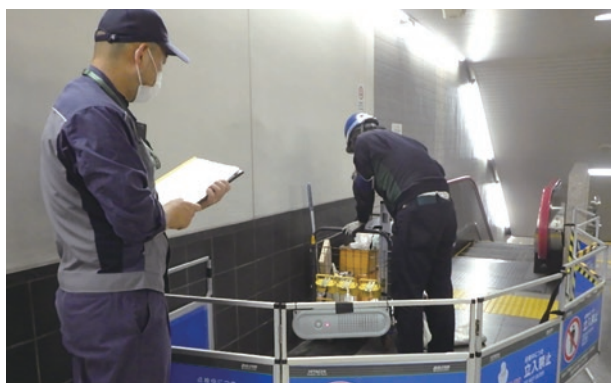
▲エスカレーターの保守点検
