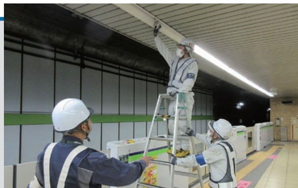
▲照明設備の清掃点検
