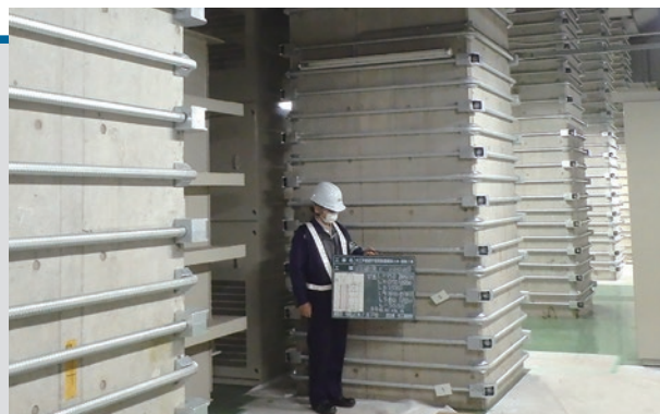
▲ 耐震補強工事（立会）
