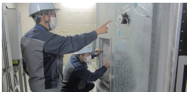
▲ 空調設備の保守点検
