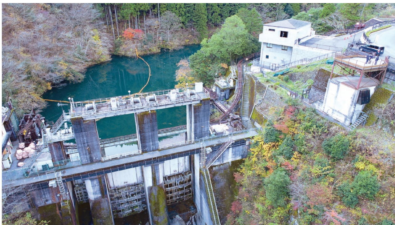
▲ 白丸調整池ダムと再生可能エネルギーPR館(エコっと白丸)
