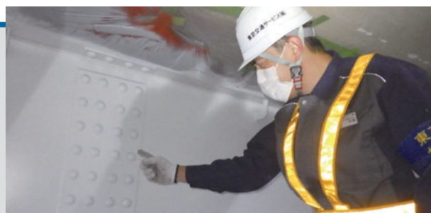
▲ 橋脚塗装工事
