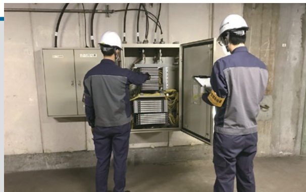
▲光ケーブル設備の保守点検
