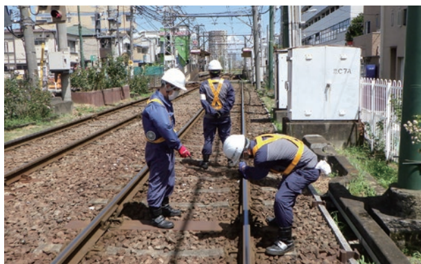
▲ レール継目部の保守点検
