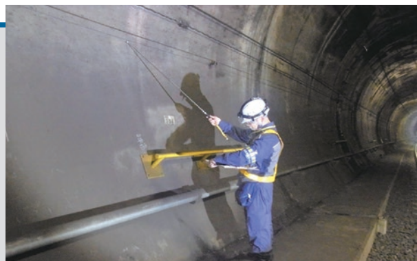
▲トンネルの点検
