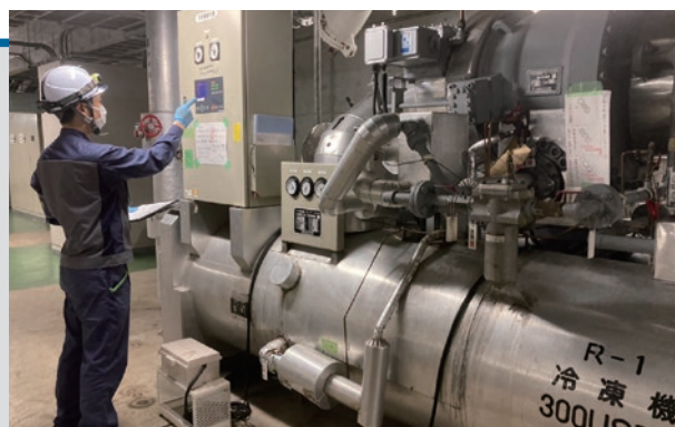
▲ 冷房設備の保守点検
