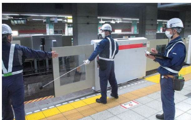
▲ ホームドアの保守点検（夜間）
