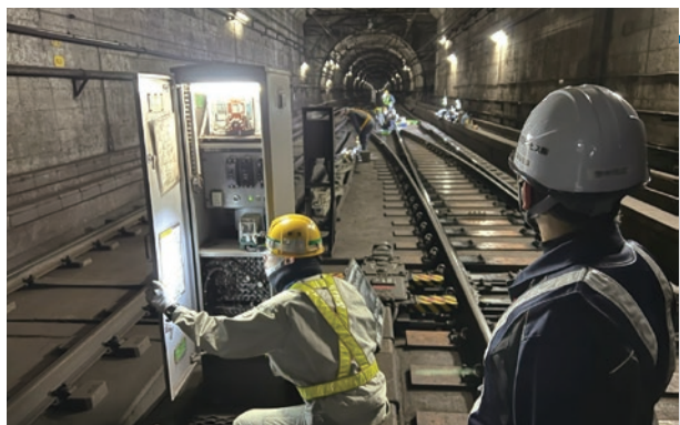
▲工事保安立会
