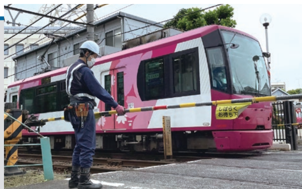
▲ 踏切保安設備の保守点検
