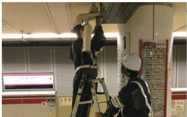
▲防犯カメラ等の保守点検
