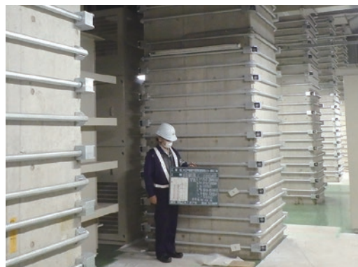
耐震補強工事監理
