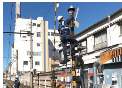
墜落制止用器具（フルハーネス）を使用した保守作業
