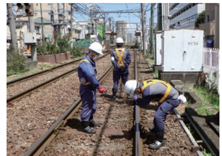
レール継目部の保守点検
