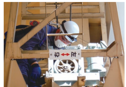
水力発電所内クレーンの保守点検
